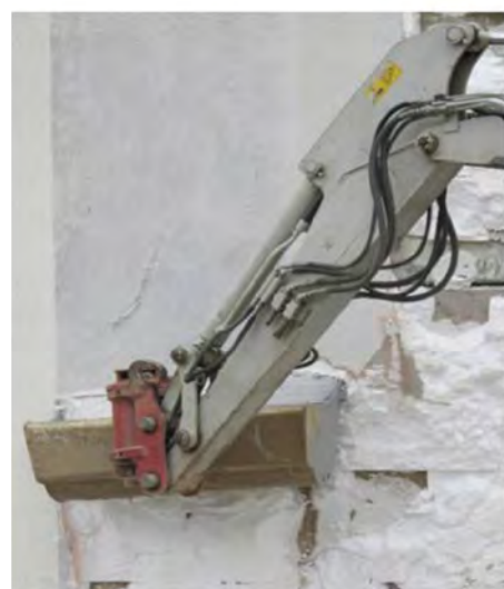
Demolizione di sistema a cappotto esistente
