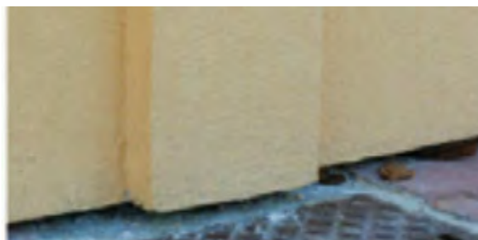
Mancata applicazione del profilo di partenza
