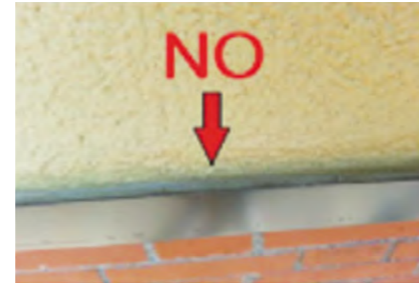
Errata sigillatura della fuga tra cappotto e profilo di chiusura
