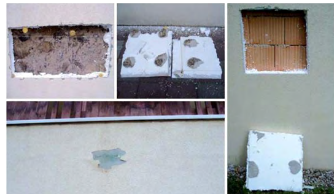
Prove di valutazione cappotti esistenti con esito negativo - non attuabile il raddoppio
