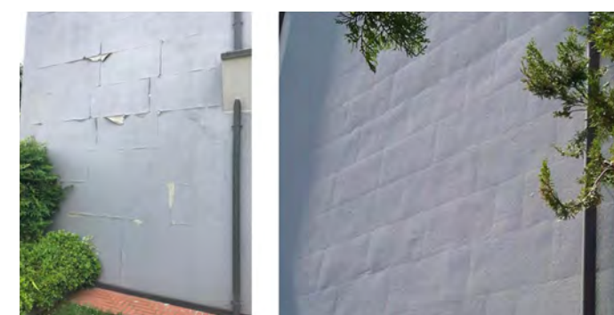
Problematiche di posa del sistema del cappotto
