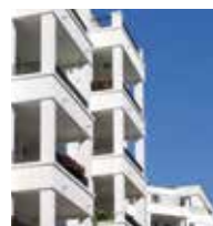
RISANAMENTO DEL CALCESTRUZZO
