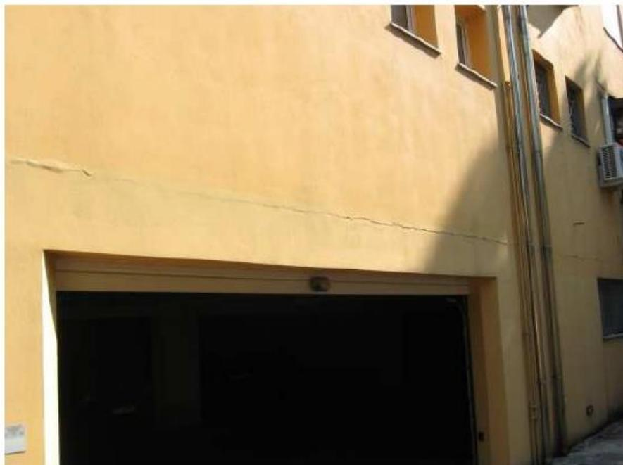
Uno dei problemi più ricorrenti è il fenomeno delle **fessurazioni sulle facciate degli edifici**. Le cause di queste fessurazioni sono molteplici e il problema è veramente molto vasto. Questa guida si occuperà in particolare delle **fessurazioni presenti sulle facciate e superfici verticali intonacate o rifinite con pitture e rivestimenti murali definiti "plastici"**. La parola "plastico" ha tratto spesso in errore sia i progettisti che le imprese e gli applicatori.
