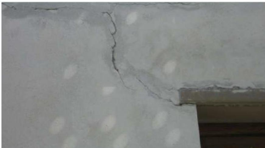
Uno dei problemi più ricorrenti è il fenomeno delle **fessurazioni sulle facciate degli edifici**. Le cause di queste fessurazioni sono molteplici e il problema è veramente molto vasto. Questa guida si occuperà in particolare delle **fessurazioni presenti sulle facciate e superfici verticali intonacate o rifinite con pitture e rivestimenti murali definiti “plastici”**. La parola “plastico” ha tratto spesso in errore sia i progettisti che le imprese e gli applicatori.
