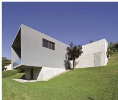
Viero: ripristino del calcestruzzo ammalorato
