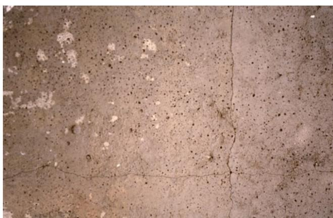
In caso di **supporto cavillato** si dovrà effettuare una nuova rasatura e rifinire e infine applicare un ciclo elastomerico.
