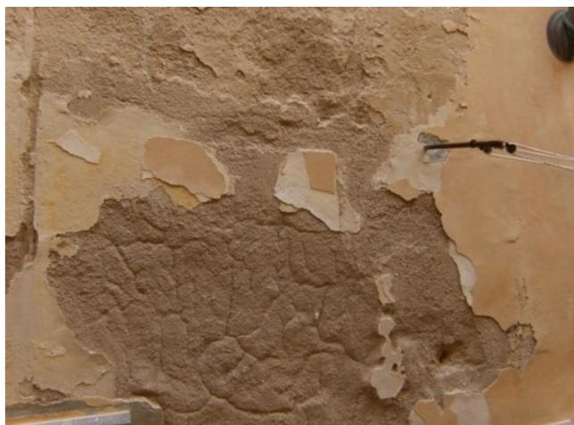
In caso di supporti con **stacchi e corrosioni parziali (rappezz)**, è necessario scrostare le parti ammalorate, ripristinare con malte simili all'esistente per durezza e composizione, lasciare stagionare, ripristinare la complanarità con rasante o fondo di riempimento, applicare nuovo rivestimento compatibile, previo primer.
