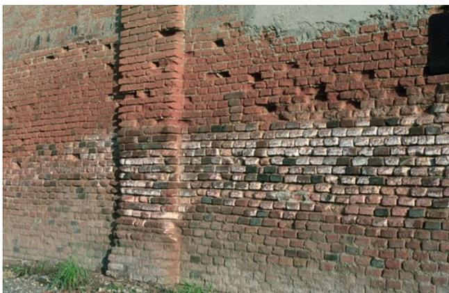
In caso di **umidità per risalita capillare**, non si dovrà trattare il supporto con alcun tipo di pittura o rivestimento. Si dovranno rimuovere le parti incoerenti, spazzolare i sali, applicare un sistema risanante. In caso di intonaco umido per imbibizione da superfici su cui ristagna l'acqua: taglio dell'intonaco.
