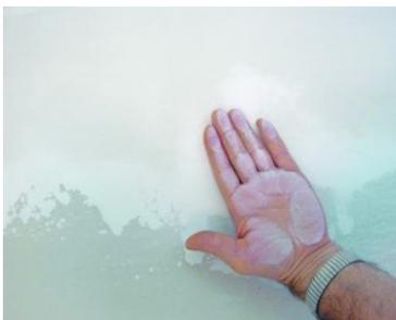
Se l'**intonaco è sfarinante** è invece necessario spazzolare energicamente fino allo strato solido, applicare un eventuale consolidante, applicare il primer specifico e rifinire.
