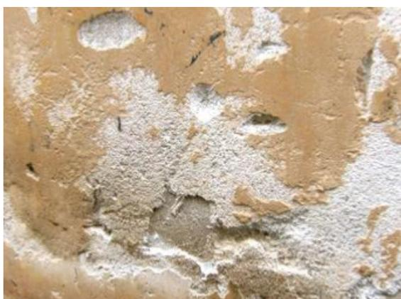
In presenza di **intonaco decoeso e inconsistente** è necessario procedere alla rimozione totale.
