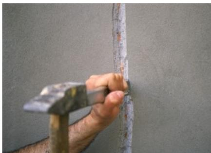
In presenza di **lesioni lineari** è necessario aprire le lesioni, ricolmare con sigillante elastico, applicare un ciclo elastomerico, oppure effettuare rasatura armata.
