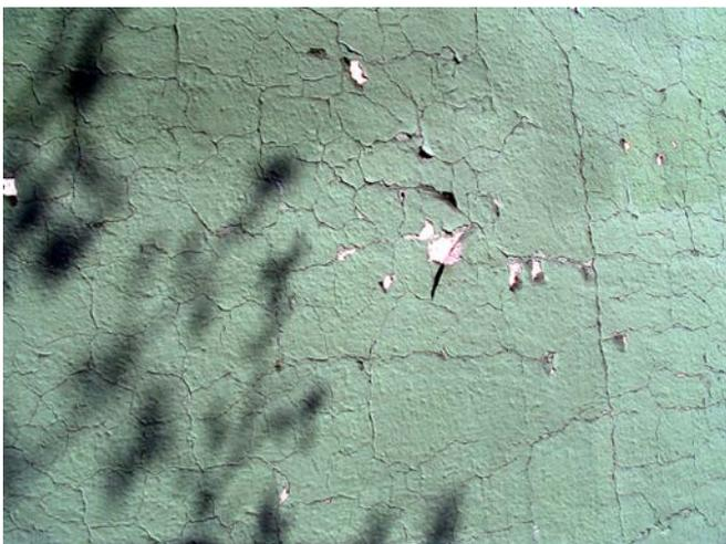
In caso di **pittura o rivestimento degradato**, è necessario rimuoverla totalmente e poi applicare il primer (a solvente per i prodotti resinati) e rifinire.
