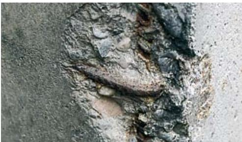
Per procedere alla corretta messa in opera del sistema per il risanamento e la protezione dei calcestruzzi ammalorati occorre procedere secondo le fasi seguenti. Scarificare il calcestruzzo con idoneo mezzo meccanico fino a portare a vista i ferri di armatura da trattare. Eliminare la ruggine dai tondini con adeguata spazzolatura, fino a riportare il ferro a lucentezza metallica. Impastare **PROFER MONO** e applicarlo a pennello sui ferri da passivare.
