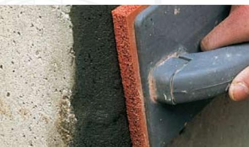
Eeguire la rasatura di finitura sul supporto umido, dopo aver impastato **TIXOCRETE CEM** o **ADESAN CPV 22** con acqua fino ad ottenere una pasta omogenea; tale pasta dovrà essere applicata con frattazzo di acciaio e rifinita con frattazzo di spugna.
