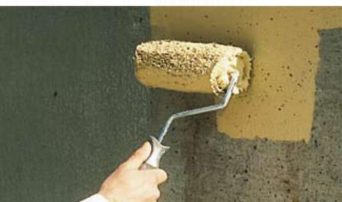
Nel caso di supporti particolarmente degradati ed assorbenti è necessaria l'applicazione preventiva di PRYMER SE o PRYMER SE PGM. Procedere quindi con l'applicazione di 2 mani di **VIEROBETON**.
